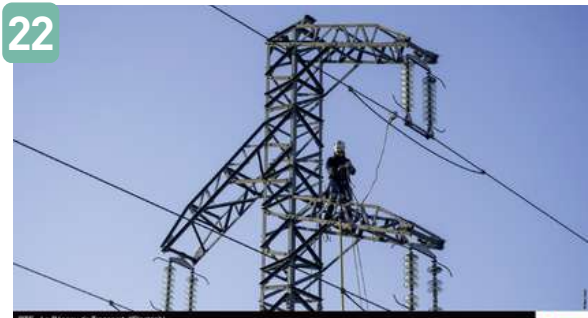
22 RTE - Le Réseau de Transport d'Électricité Un équipier de maintenance des lignes aériennes met à la terre les conducteurs de la ligne à 90 000 Volts reliant les villes de Saumur et Montreuil-Bellay (Maine-et-Loire) à la ville de Thouars (Deux-Sèvres), en vue du remplacement des isolateurs électriques.
